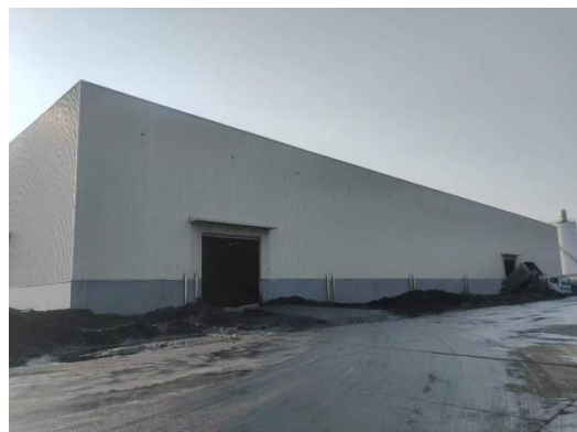
事故临时堆场
