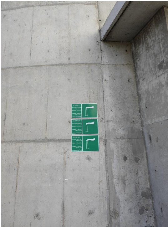
废气排放口标识牌
